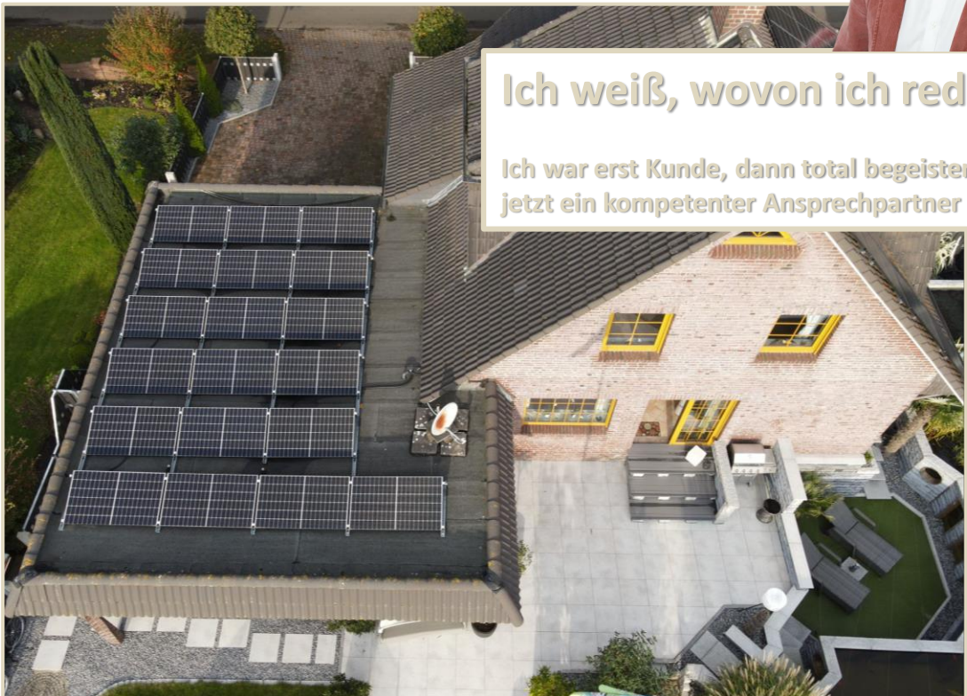
19 Module – Süd-West Ausrichtung – 6,937 KWp
