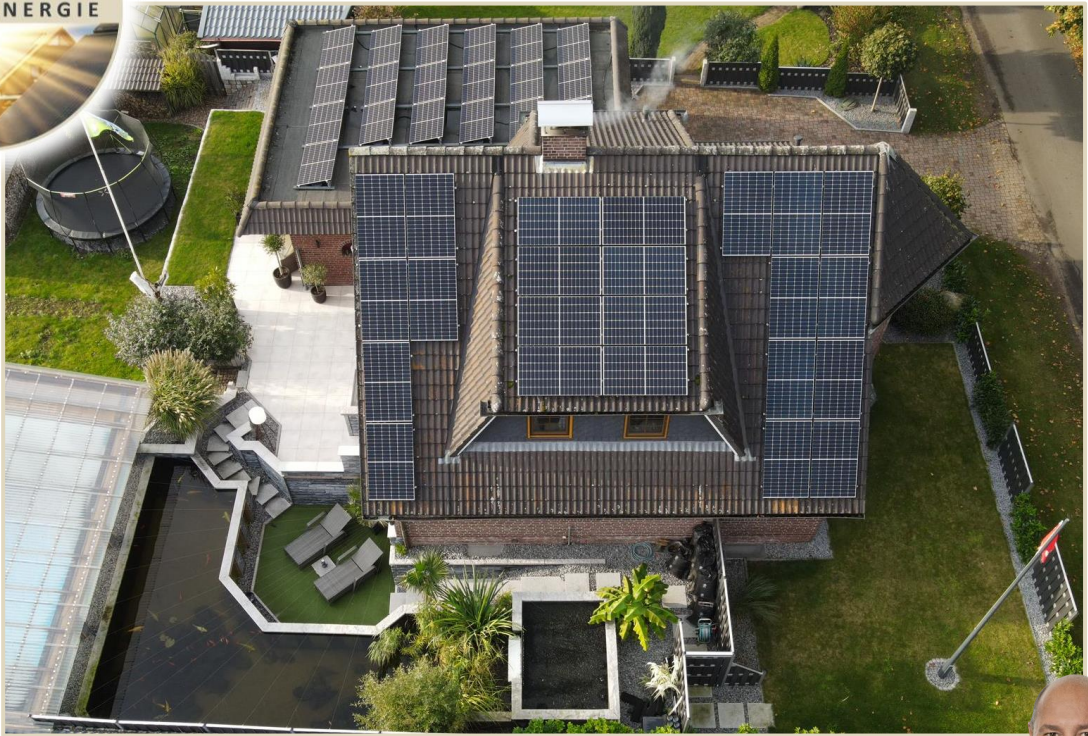
23 Module – Ost Ausrichtung – 8,395 KWp
