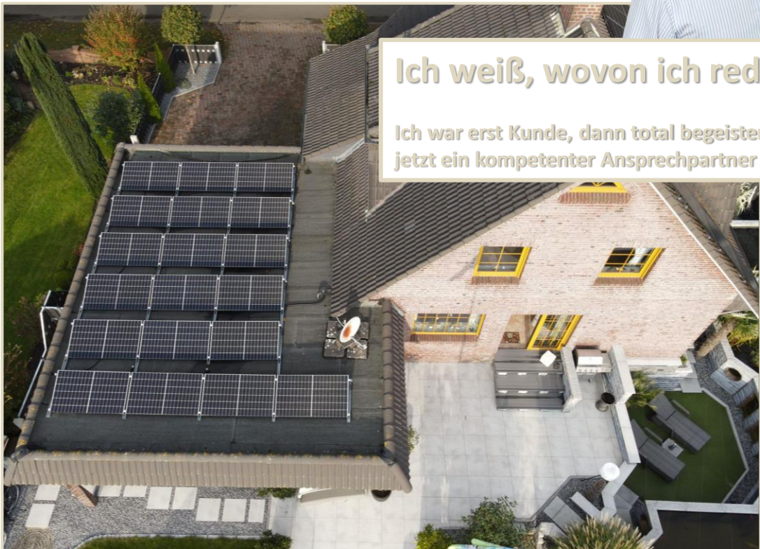
19 Module – Süd-West Ausrichtung – 6,937 KWp
