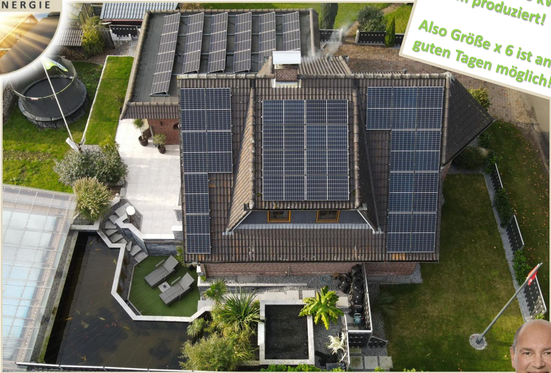
23 Module – Ost Ausrichtung – 8,395 KWp
